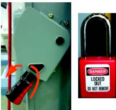
Rysunek 1-32 Blokowanie dźwigni wyłącznika
