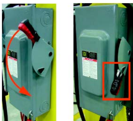
Rysunek 1-31 Wyłączanie głównego wyłącznika bezpieczników
