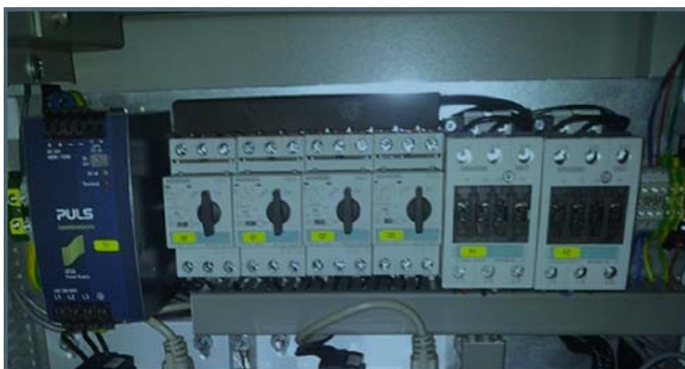
Rysunek 6 - 2 Odłączanie zasilania za pomocą bezpiecznika automatycznego
