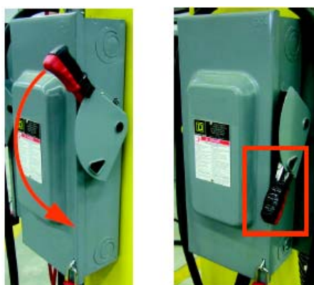
Rysunek 1-31 Wyłączanie głównego wyłącznika bezpieczników
