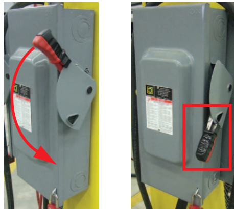
Figura 1-26 Ustawianie głównego wyłącznika prądowego w wyłączonej pozycji
